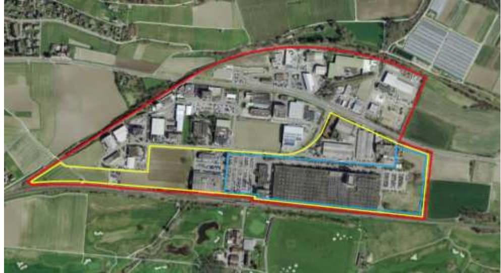
Abb. 46: Orthofoto Arbeitsplatzgebiet Otelfingen mit Bauzonengrenze (rot), südlichem Teil des Arbeitsplatzgebietes (gelb) und Eigentum der SPS (blau) (Quelle: swisstopo, 2015)
